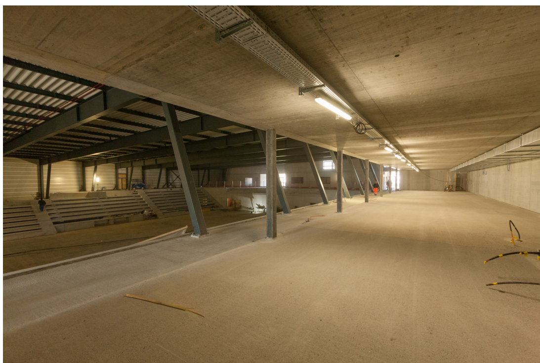
Der Innenausbau hat begonnen – hier die künftige Bärenclub-Lounge
