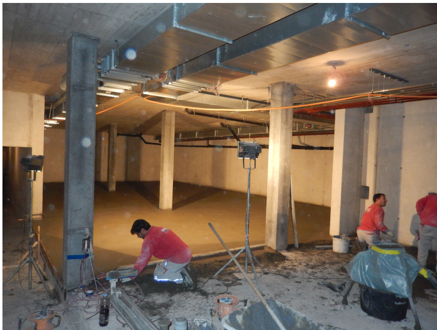
Der unterste Bodenbelag des künftigen Fitnessraums ist eben fertiggestellt.
