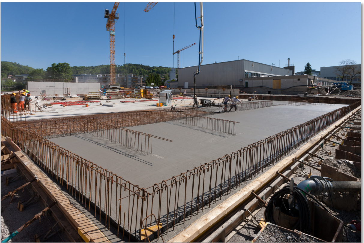
... und fertig ist die Bodenplatte
