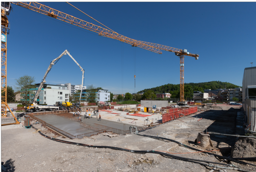
Die Baustelle Mitte Mai 2017
