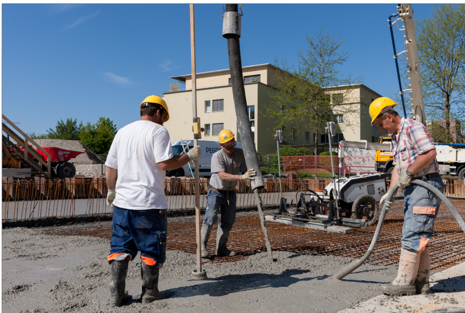
Die letzten Betonierungsarbeiten ...
