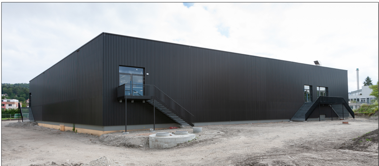
Die Hinterseite der Halle nach der Befestigung der Notausgangstrepfen
