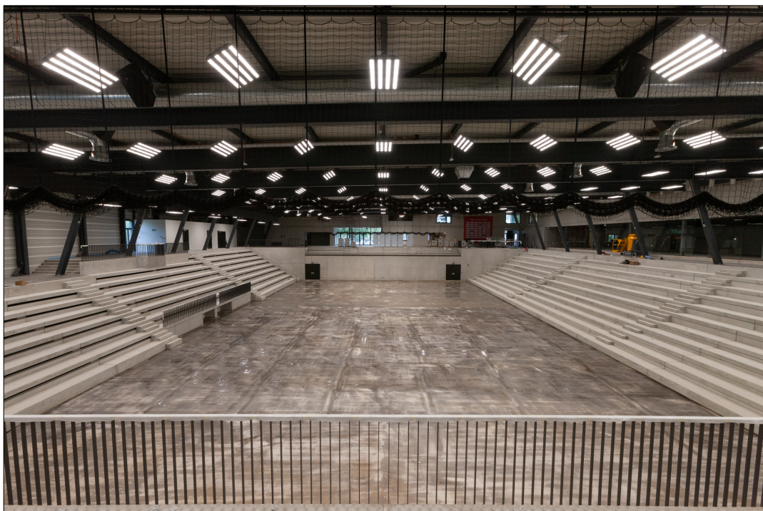
Das Innere der Halle vor dem Einbau des Sportbodens und der Bestuhlung
