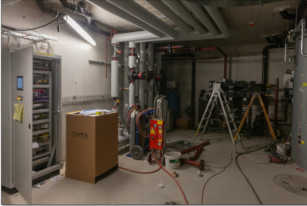
Blick in die Energiezentrale – oben die Heizwasseranschlüsse aus dem GBM-Wärmeverbund... ... unten einer der 3 Warmwassertanks für das auf dem Energiedach produzierte Duschwasser
