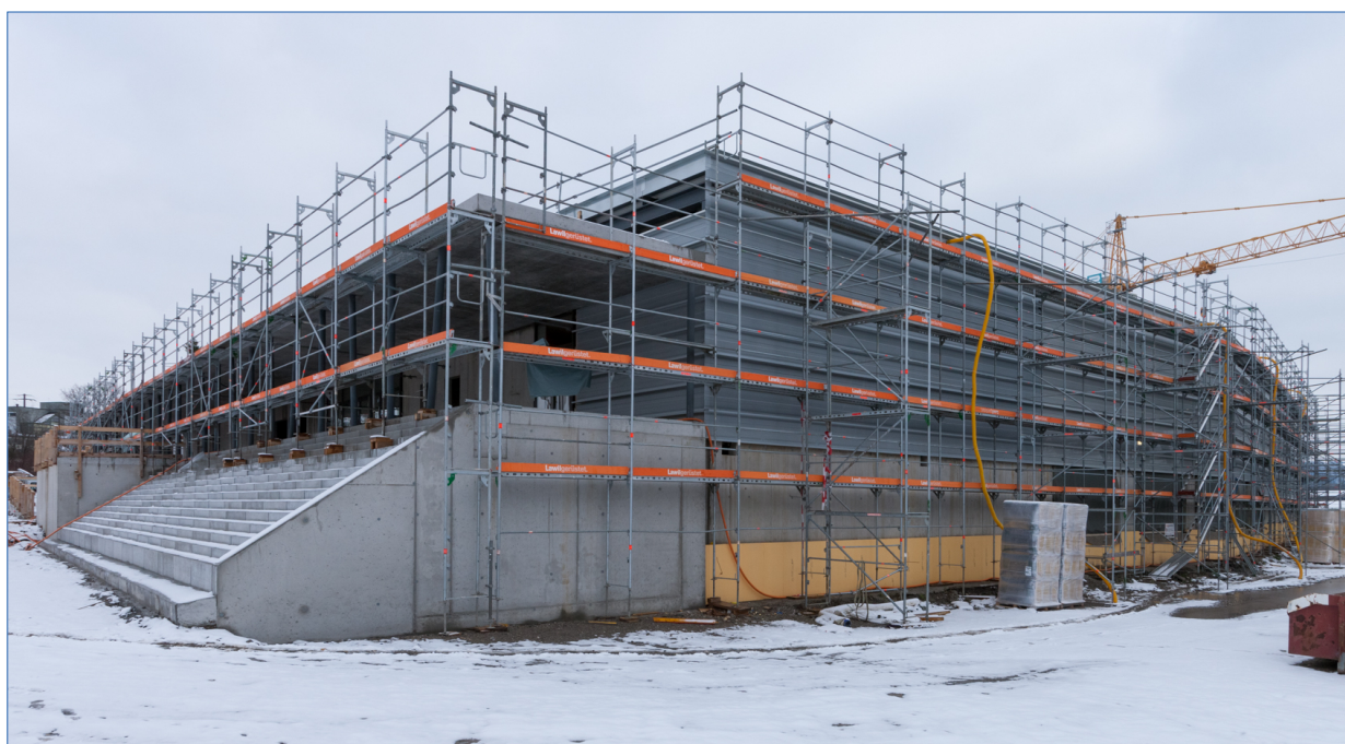
So sieht die Baustelle Ende 2017 aus
