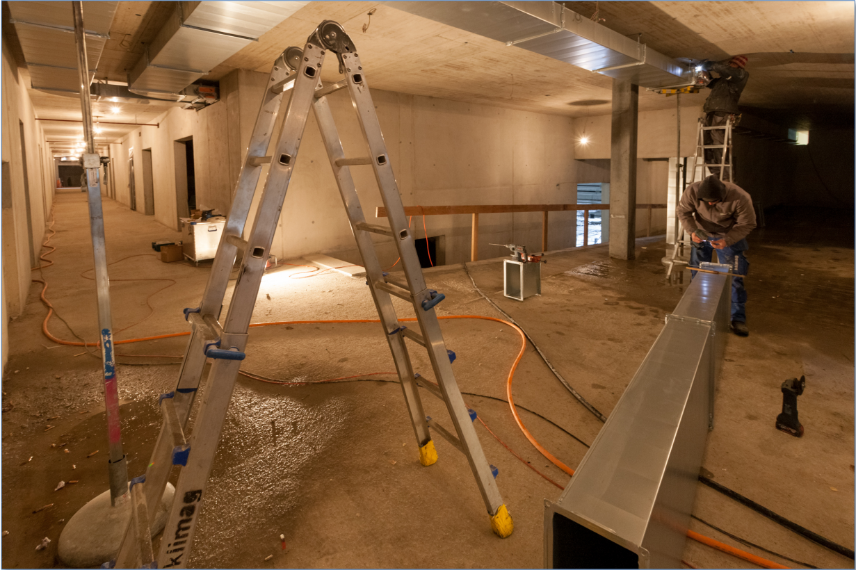
In zahlreichen Räumen des Untergeschosses wurden bereits hunderte von Laufmetern Luftkanäle für die ausgeklügelte Heizungs- und Belüftungsanlage der Ballsporthalle präpariert und montiert.
