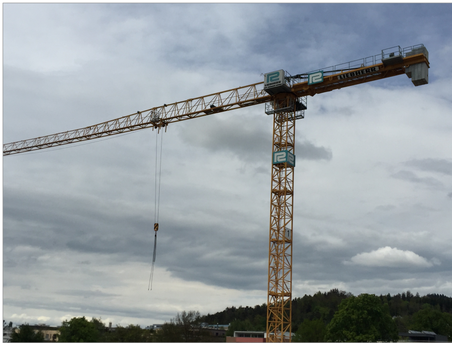
.. und fertig war der Kran
