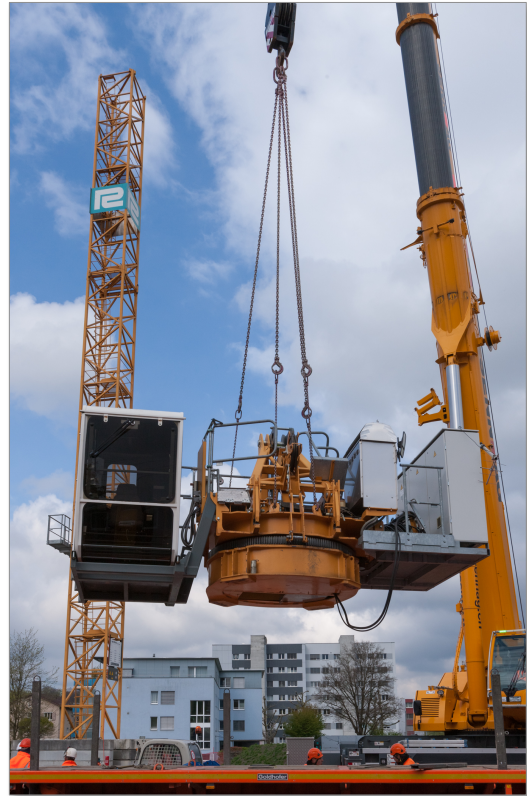
... und dann noch die Kranführer-Kabine ...
