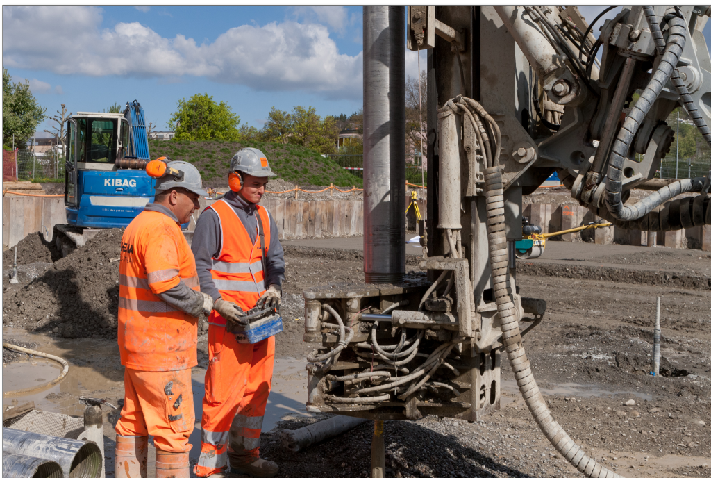
178 Pfähle werden gesetzt
