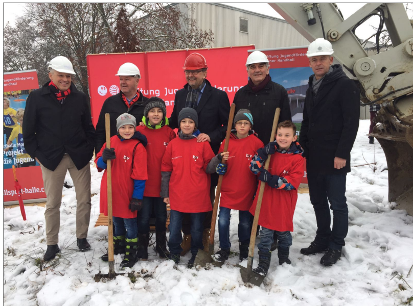
Spatenstich am 6. Februar 2017
