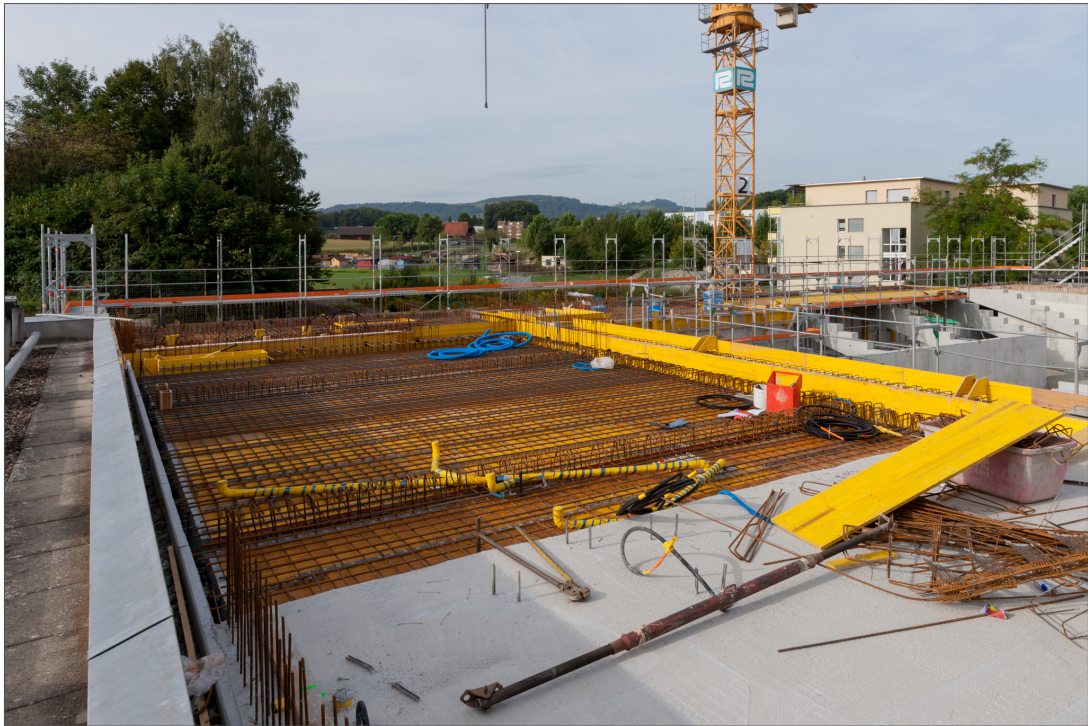
Verlegen der Armierungen und Leitungen im Bereich des grossen Restaurants
