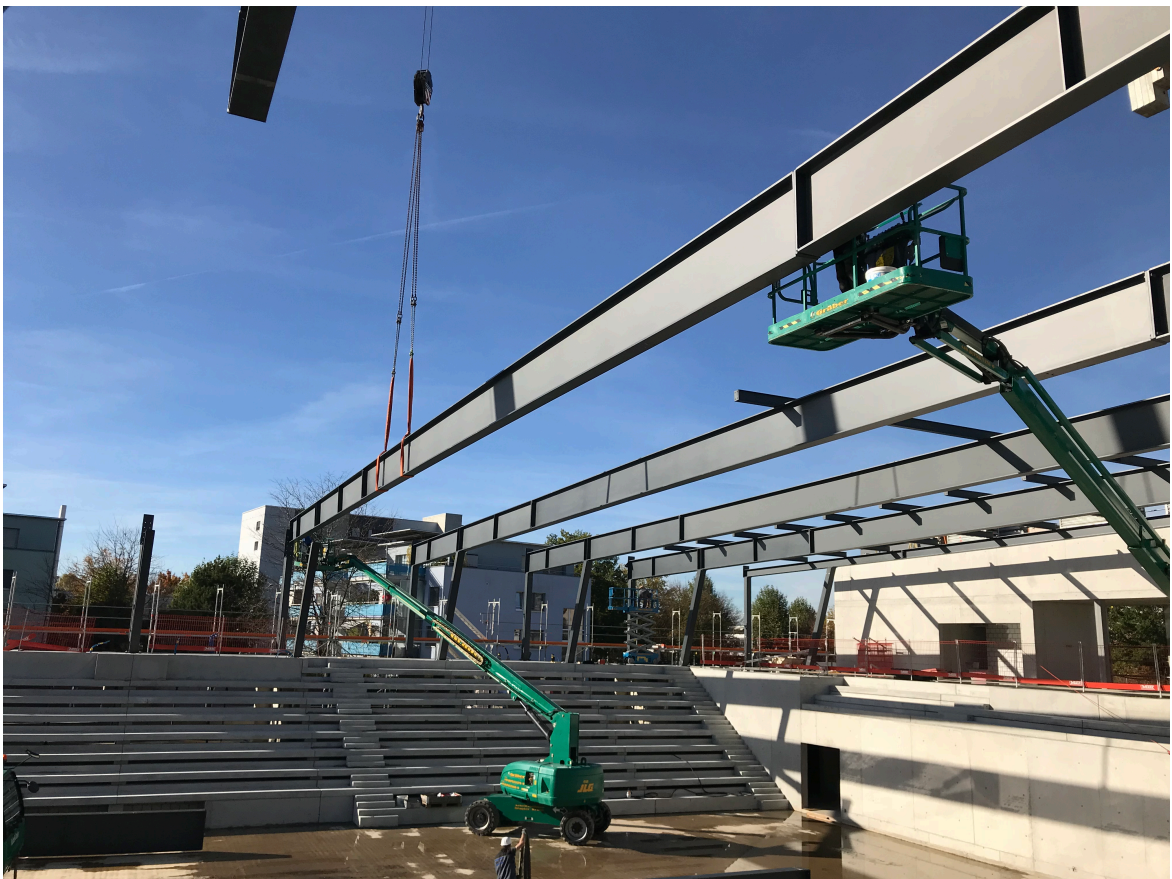
Impressionen von der Montage der Stahlkonstruktion des Hallendachs
