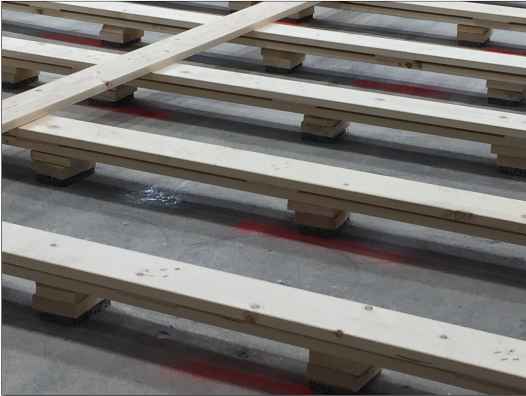
In mühsamer Kleinarbeit legten 6 Mitarbeiter der Firma Walo Bertschinger AG tausende von unterschiedlich dicken Hölzchen unter die Latten, um den Boden völlig plan zu machen.
