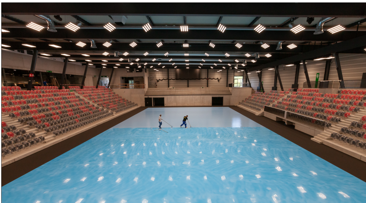
Das Innere der Halle während des Einbaus des Sportbodens
