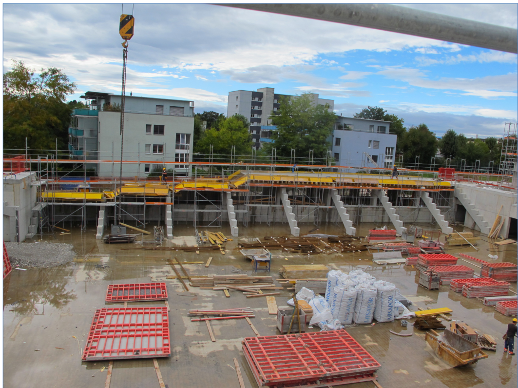
Die Vorbereitungen für den Bau der Bodenplatte des Erdgeschosses oberhalb der West-Tribüne
