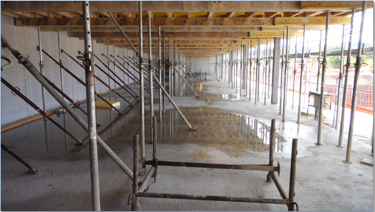
Das künftige Restaurant der Bärenclub-Lounge erhält seine Decke
