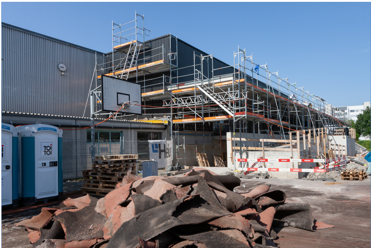
Der alte Belag des roten Sportplatzes wurde entfernt und wird kurz vor Fertigstellung der Halle durch einen neuen Belag ersetzt
