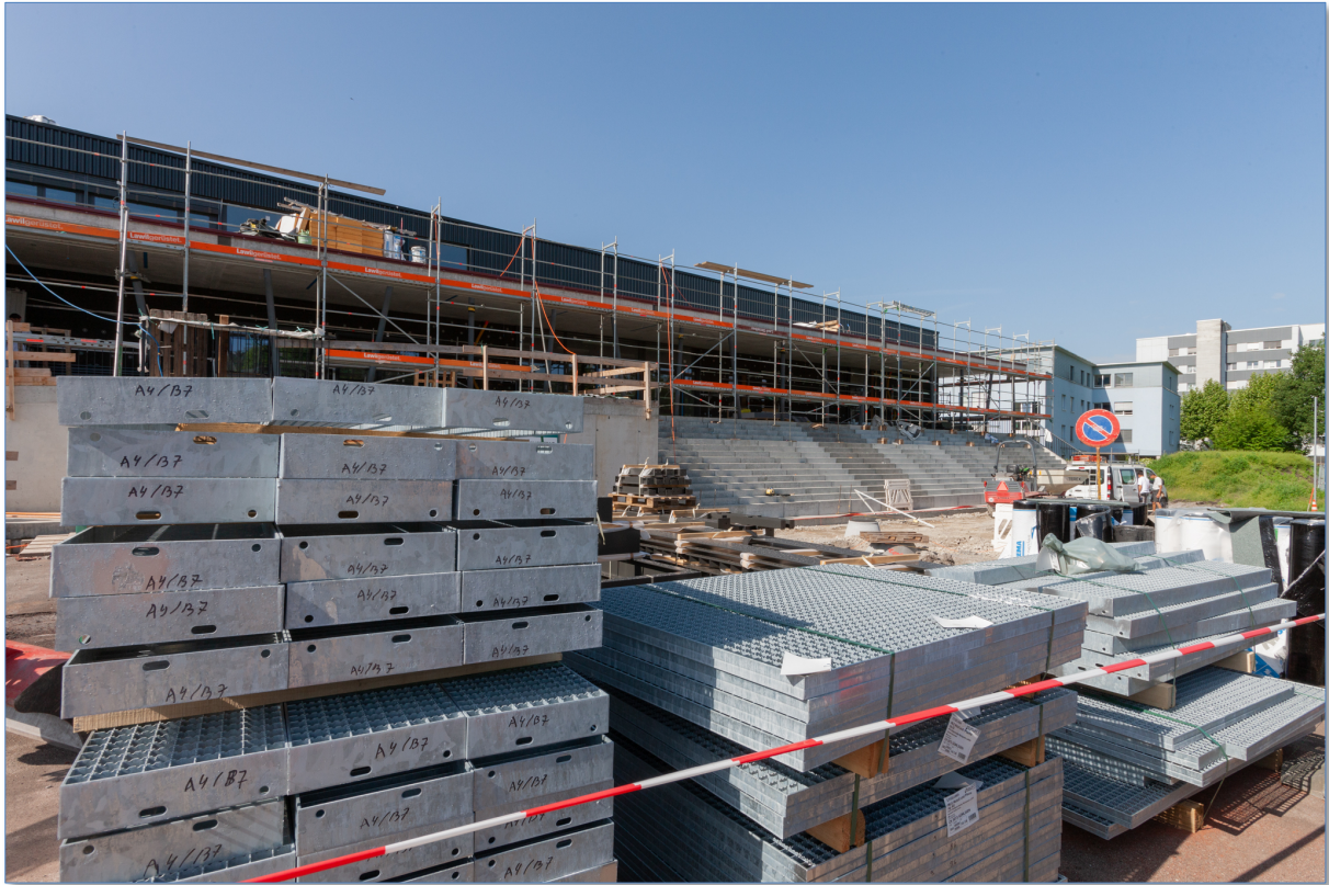
Das Material für die Notausgangstreppen liegt auch schon bereit
