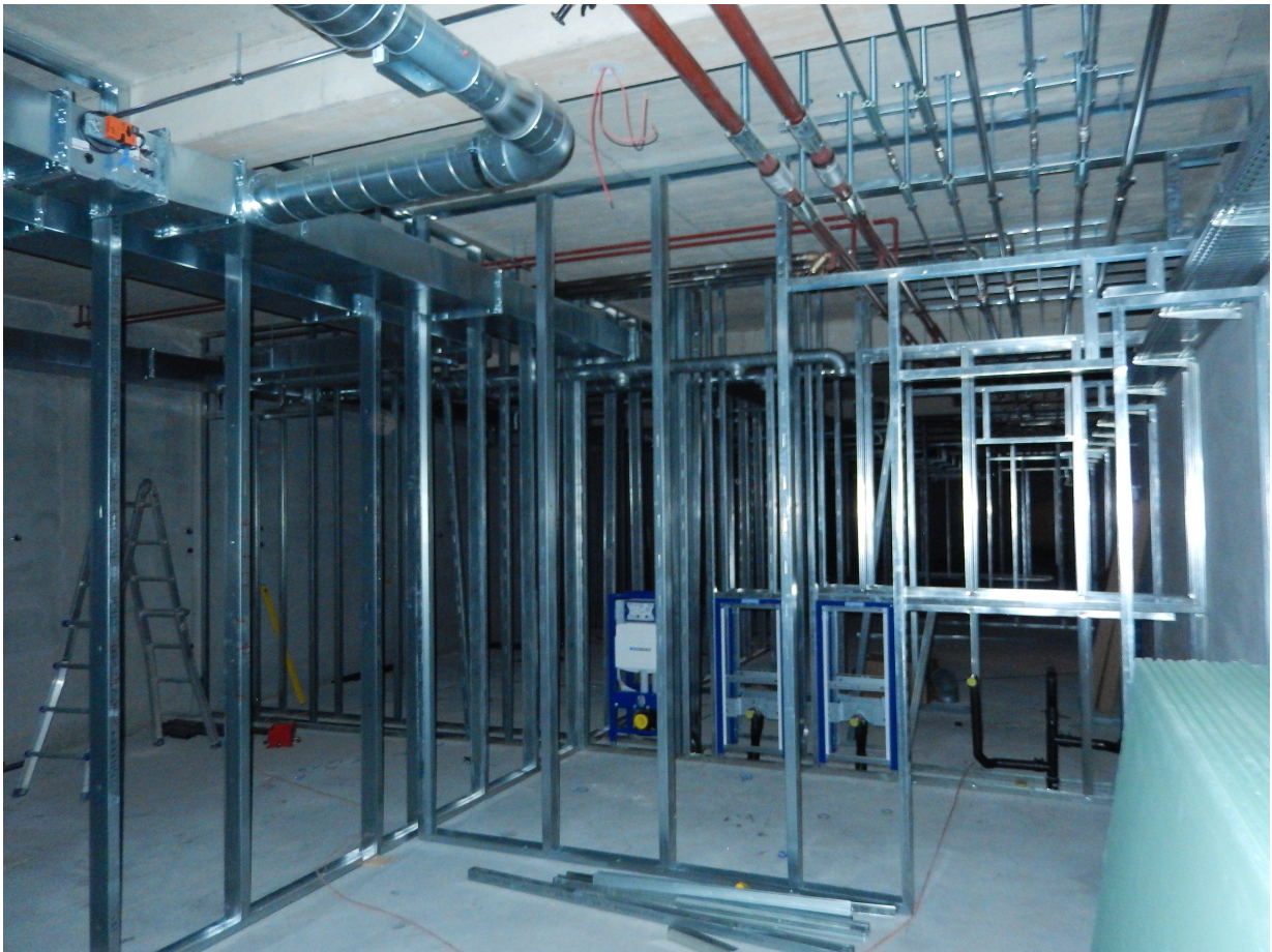
1. Phase: Installationen der Schienen für die späteren Trennwände
