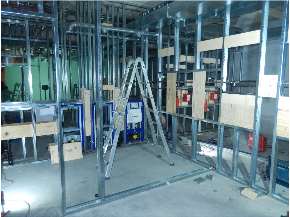
2. Phase: Installation von Apparaten und Leitungen in den Trennwänden
