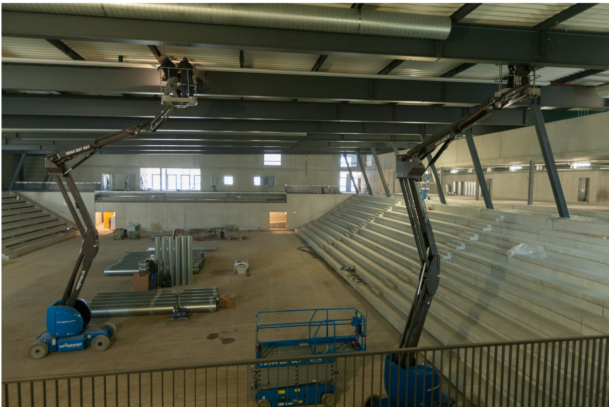
Anspruchsvolle Montage der grossen Lüftungsrohre an der Hallendecke
