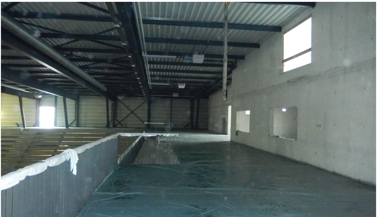
Oben: der Unterlagsboden der Eingangshalle entsteht - unten: fertig
