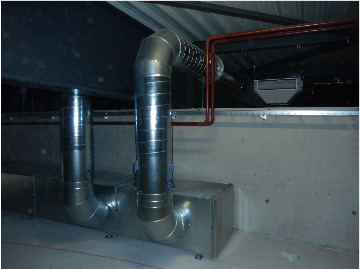
Anspruchsvolle Montage der grossen Lüftungsrohre an der Hallendecke
