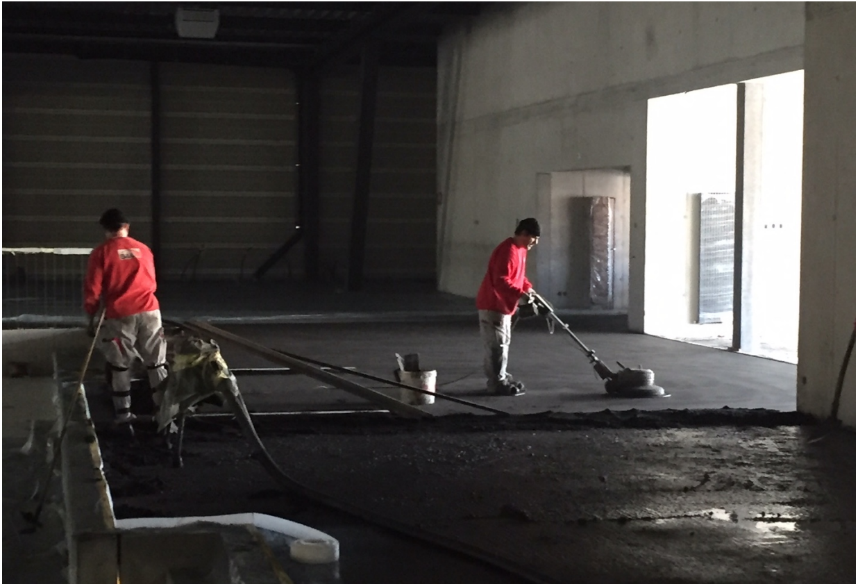
Oben: der Unterlagsboden der Eingangshalle entsteht - unten: fertig
