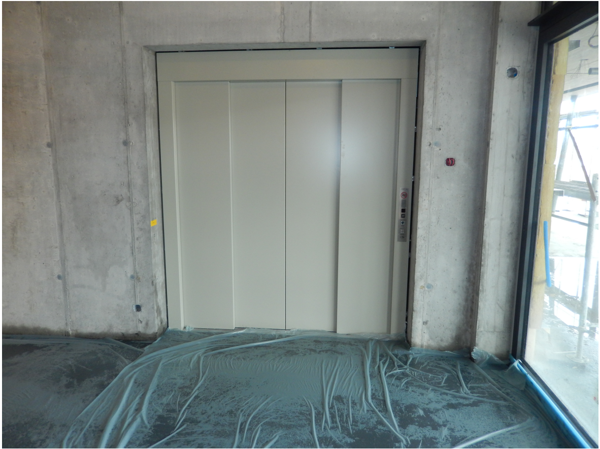
Die Lifttüren sind zwar fertig – dahinter aber noch alles in Montage
